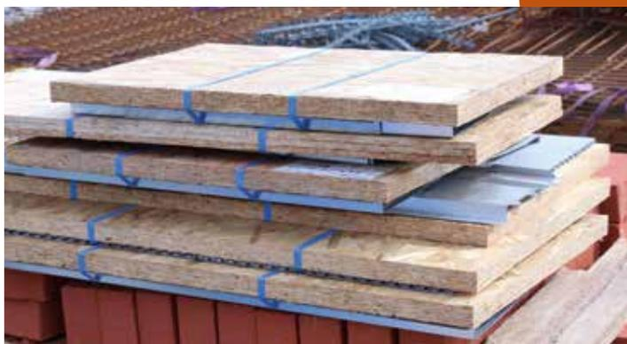
Boîte tri-matière livrée en kit pour optimiser le stockage sur le chantier.
